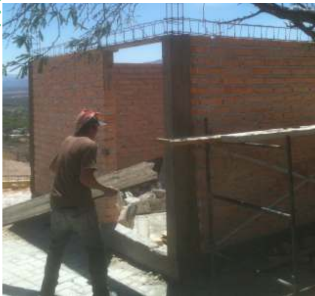
Construcción de Bodega en el Panteón Municipal.
