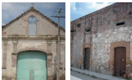
Fachada de la ex hacienda la Laja (San Isidro)
